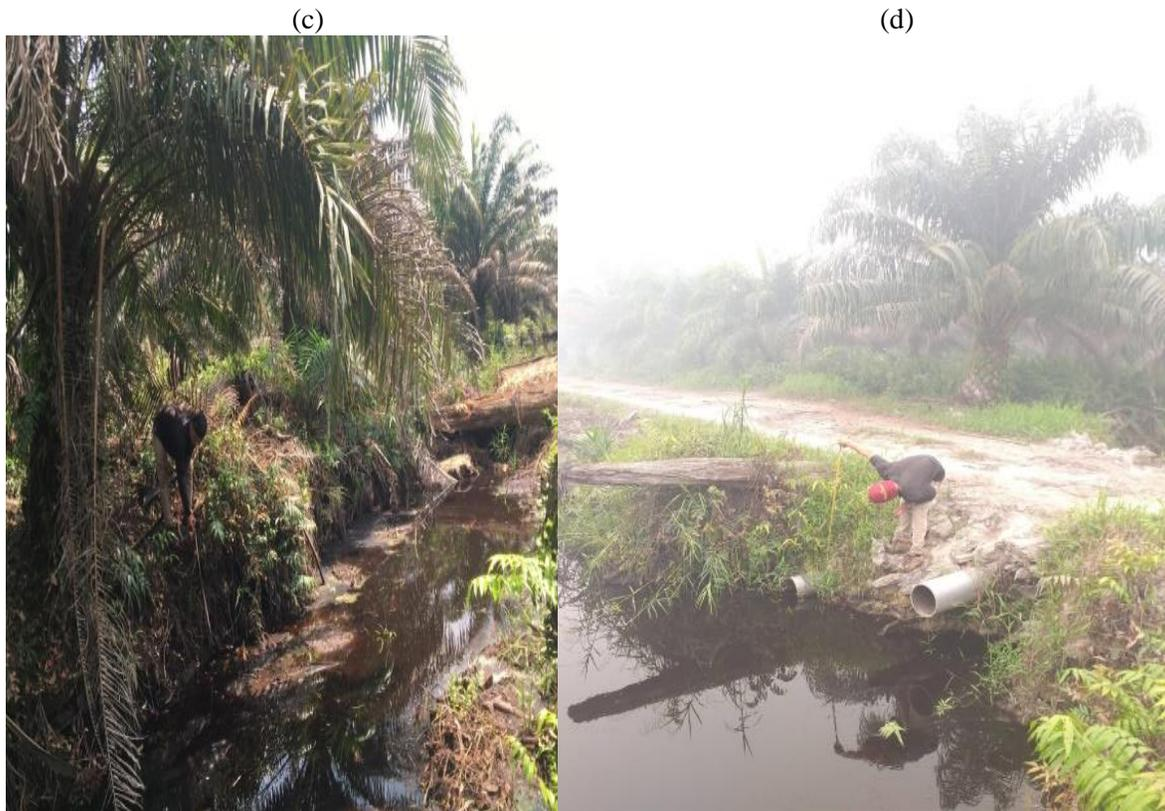
Gambar 3. Saluran drainase gambut terbakar (a), saluran drainase gambut tidak terbakar (b), sekat kanal dalam drainase (c), dan sekat kanal persimpangan kanal dan jalan (d)
